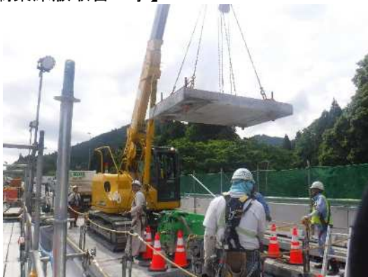
老朽化した床版の撤去状況
