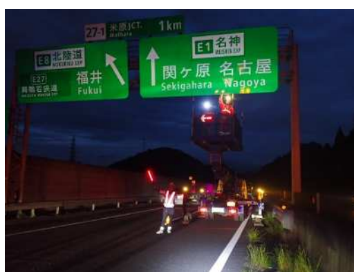
標識の点検状況
