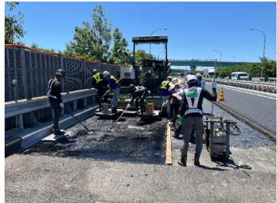
床版防水の施工状況
