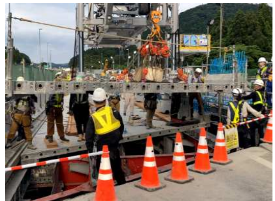
新しい床版の設置状況
