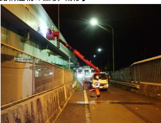
橋梁の点検状況
