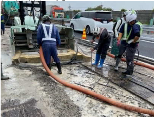
老朽化した床版の補修状況
