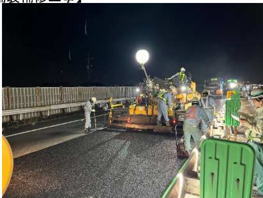
アスファルト舗装の施工状況
