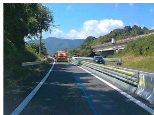
【仮設防護柵（バルカンバリア）設置状況】
