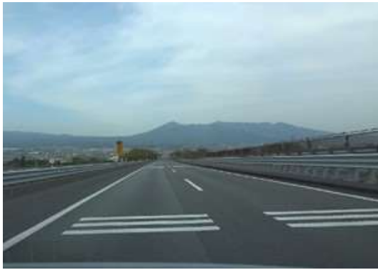
【突起型路面標示】
