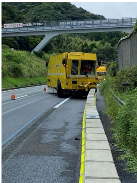
【移動式防護柵（Road Zipper System） 作業状況】
