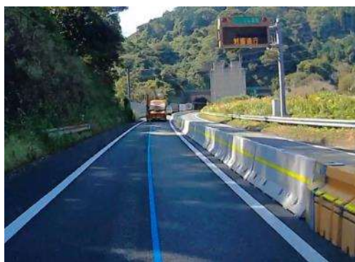
【仮設防護柵（SSS ガード）設置状況】
