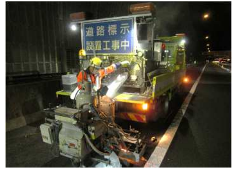
路面標示施工状況
