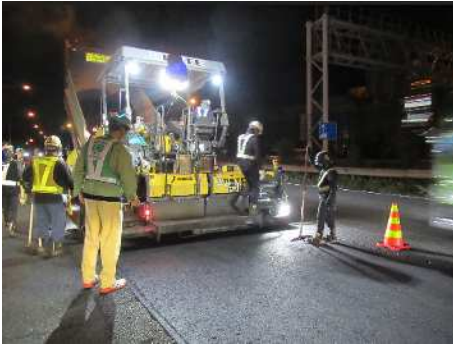
アスファルト合材舗設状況
