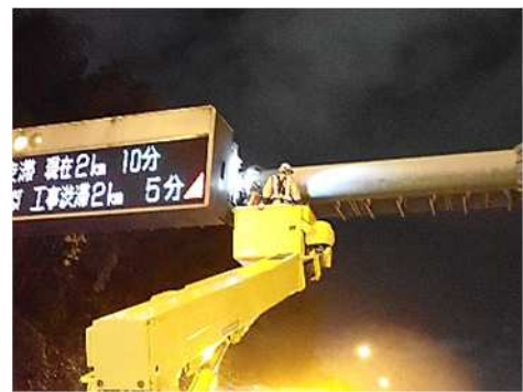
道路情報板設備点検状況
