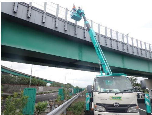
橋梁点検状況
