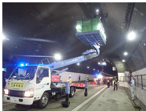
トンネル点検状況
