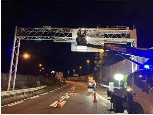
標識点検状況
