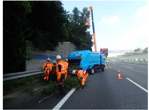
樹木伐採状況
