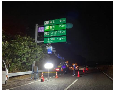
標識点検状況
