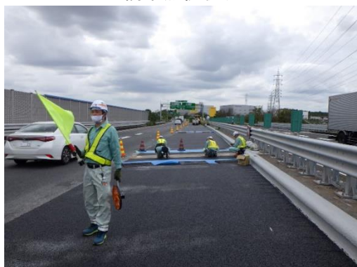
伸縮装置点検状況
