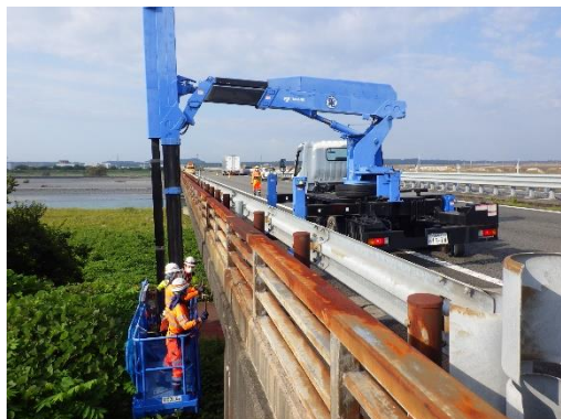
橋梁点検状況
