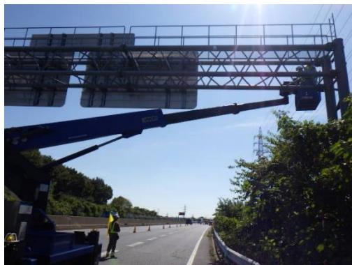
標識点検状況
