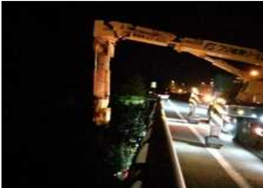
橋梁詳細点検
