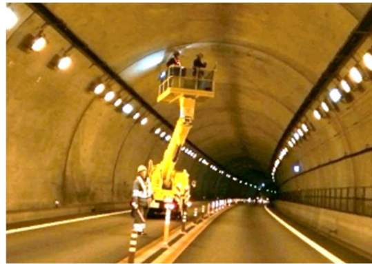
トンネル点検
