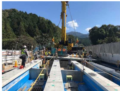
床版取替 施工中
