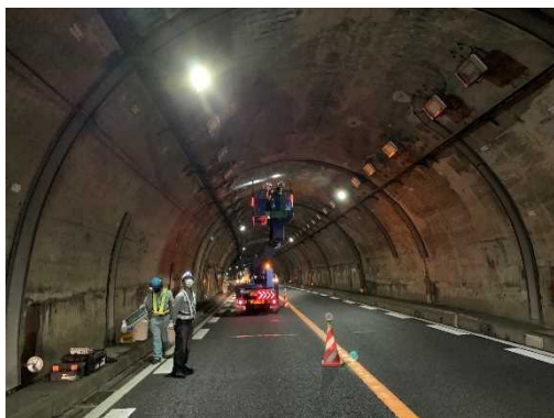
トンネル点検
