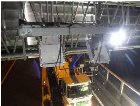
ETC 無線通信アンテナ点検
