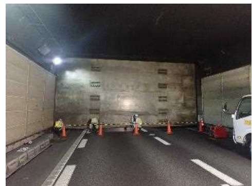
制水ゲート点検
