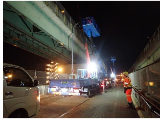
道路照明点検状況
