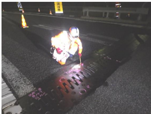
伸縮装置点検状況
