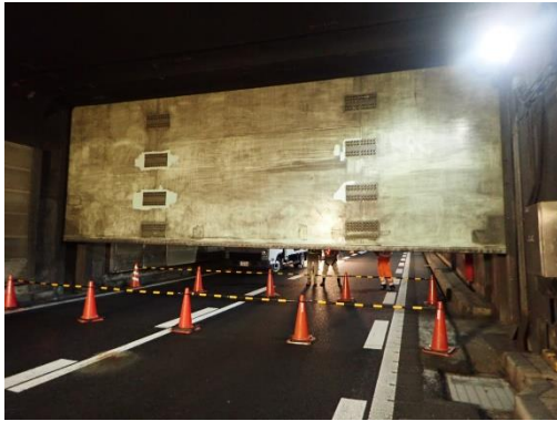
制水ゲート点検状況
