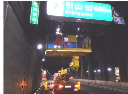
標識点検状況
