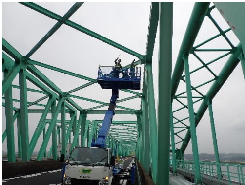
橋梁点検状況
