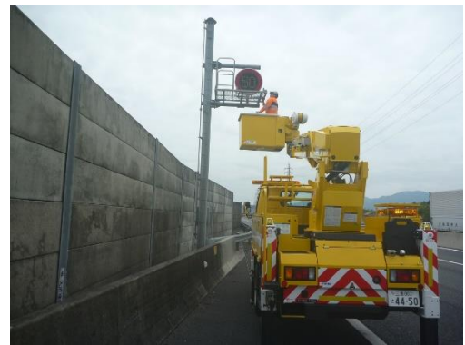
標識点検状況
