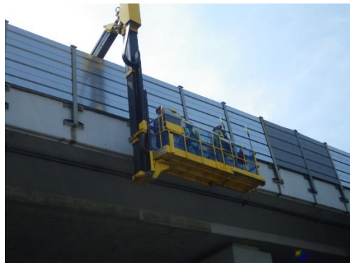
遮音壁点検状況
