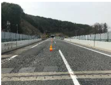
施工前（小田井高架橋）
