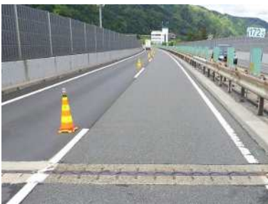
施工前（上金子高架橋）
