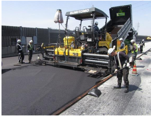
舗装補修状況
