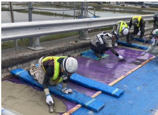
橋梁路肩部の補強
