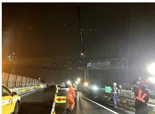
門型標識の撤去
