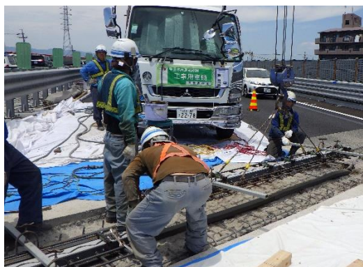
橋梁の伸縮装置取り替え
