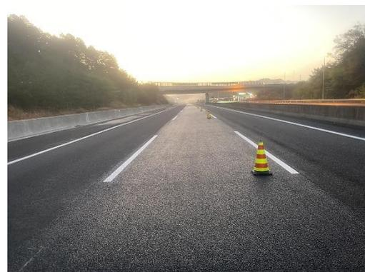
○傷んだコンクリート床版の補修をおこないました。また、橋梁の劣化の要因となる凍結防止剤や水がコンクリート床版に浸透するのを防ぎ、構造物の長寿命化を図るための高性能床版防水工を施工しました。
