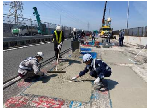
床版補修状況
