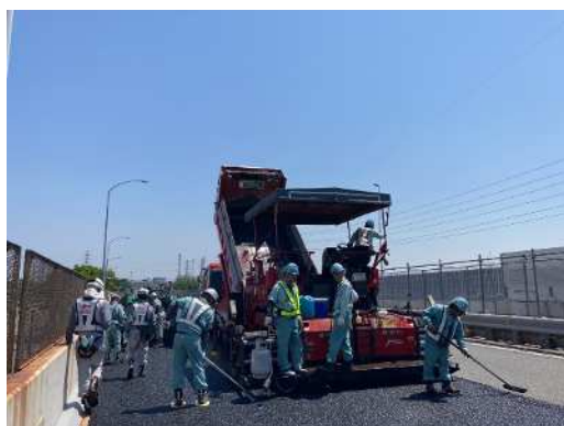
舗装補修状況
